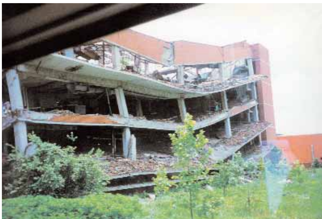
Ostaci zgrade »Borovo-Commercea« u Borovu Naselju, razrušene u završnom napadu JNA 18. i 19. studenoga 1991.; fotografija snimljena nakon srpske okupacije (autor fotografije: mr. sc. Božo Biškupić)
