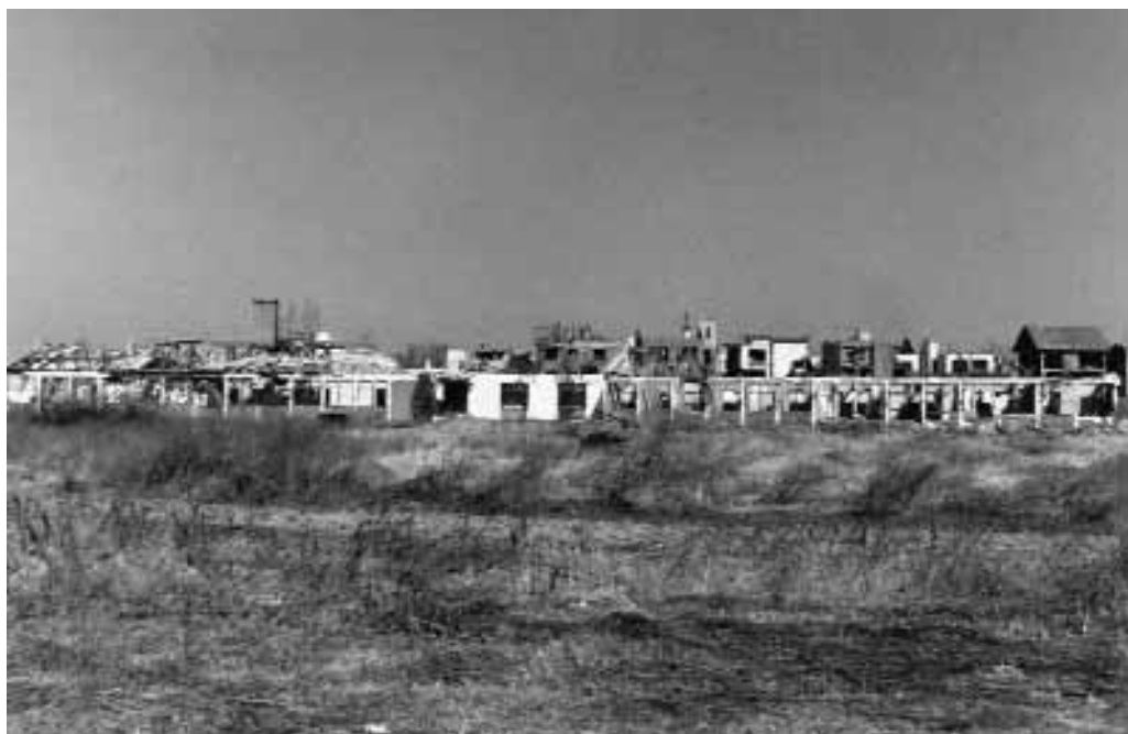
Porušeni Dom starih
